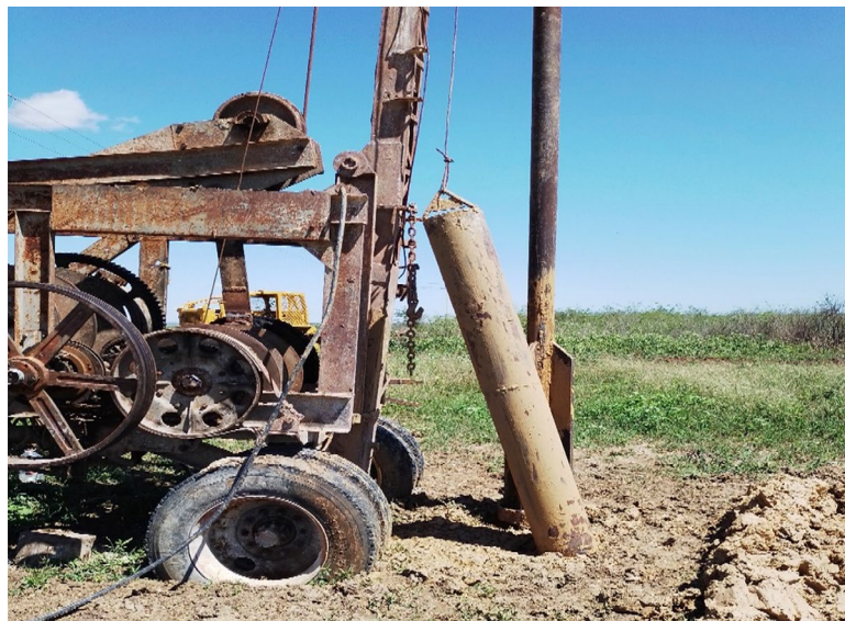
Figura 4. Equipo para la perforación de pozos en la colonia Santa Fe.
