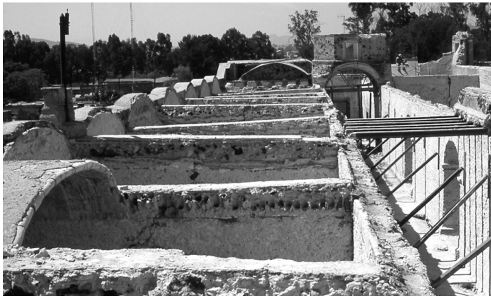
Figura 11. Bóvedas en planta alta demolidas en fecha desconocida.
