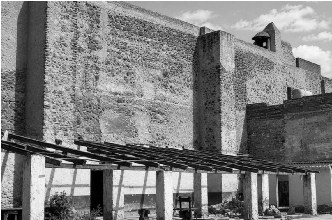
Figura 6. Muro posterior del Claustro Mayor. Adheridos los talleres de los reclusos.
