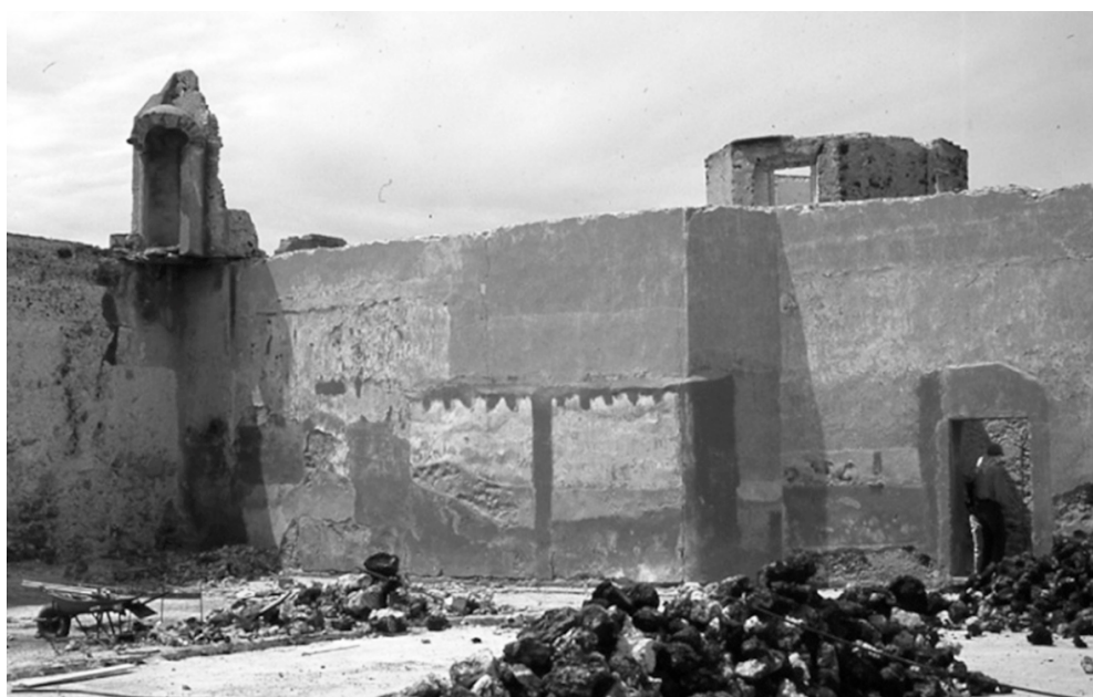
Figura 10. Espacios en planta alta demolidos en fecha desconocida.
