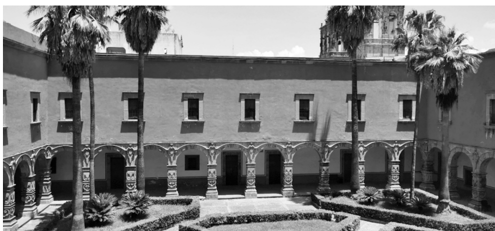
Figura 13. Patio central del Claustro Mayor. Fuente: Barrera Rios (2026).
